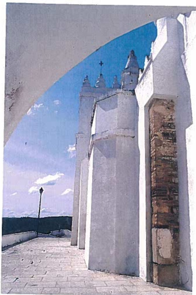
Contraforte da mesquita
